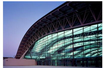
メインターミナルビル テフロン膜の天井面を外部から望む (22)
