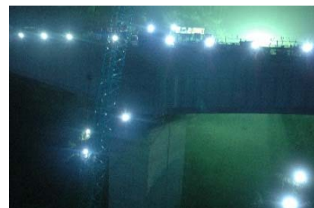
土木学会により「土木のイノベーション10選」に選ばれた可視光通信測量システム
